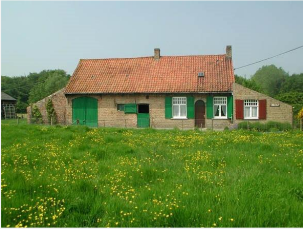
Fig. 9: Vladslo (Diksmuide), een kleine hoeve van het langgeveltype (Onroerend erfgoed).
