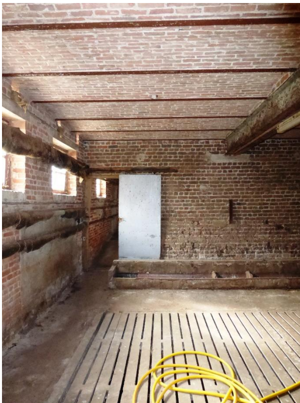
Fig. 36: zoldering van troggewelven in de koestal op de hoeve Pilkemseweg 130* in Boezinge (Onroerend Erfgoed).
