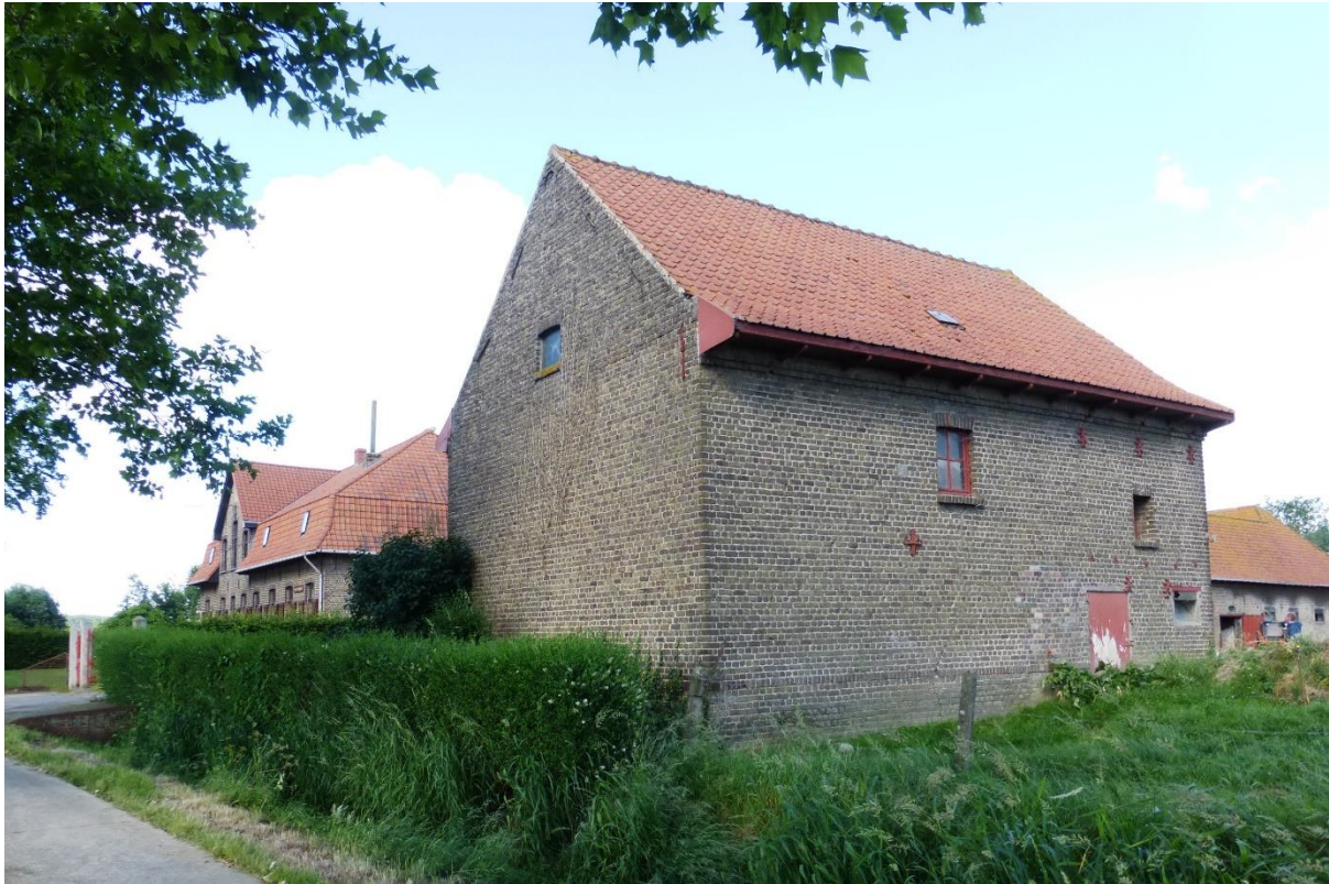
Fig. 54: de ast bij de hoeve 'West-Bellegoed'* in Voormezele (Onroerend Erfgoed).
