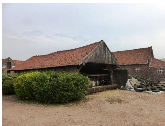
Fig. 44: de overdekte mestvaalt op de wederopbouwhoeve 'Cense du Don' in Nieuwkerke (Onroerend Erfgoed).
