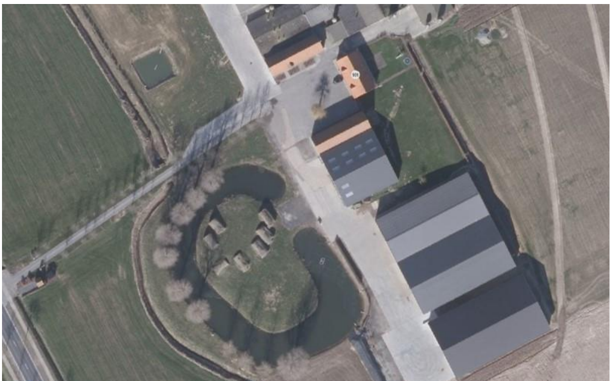
Fig. 10: luchtfoto van de hoeve 'Langhof' in Zillebeke met op het opperhof Britse bunkers (Geoportaal - geo.onroerenderfgoed.be).
