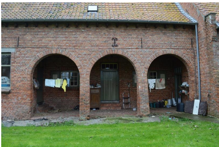
Fig. 26: arcade van drie rondbogen met toegang tot het melkhuis en het voederhok tussen de boerenwoning en de koestal op de hoeve 'Oosthof'* in Ramskapelle (Onroerend Erfgoed).
