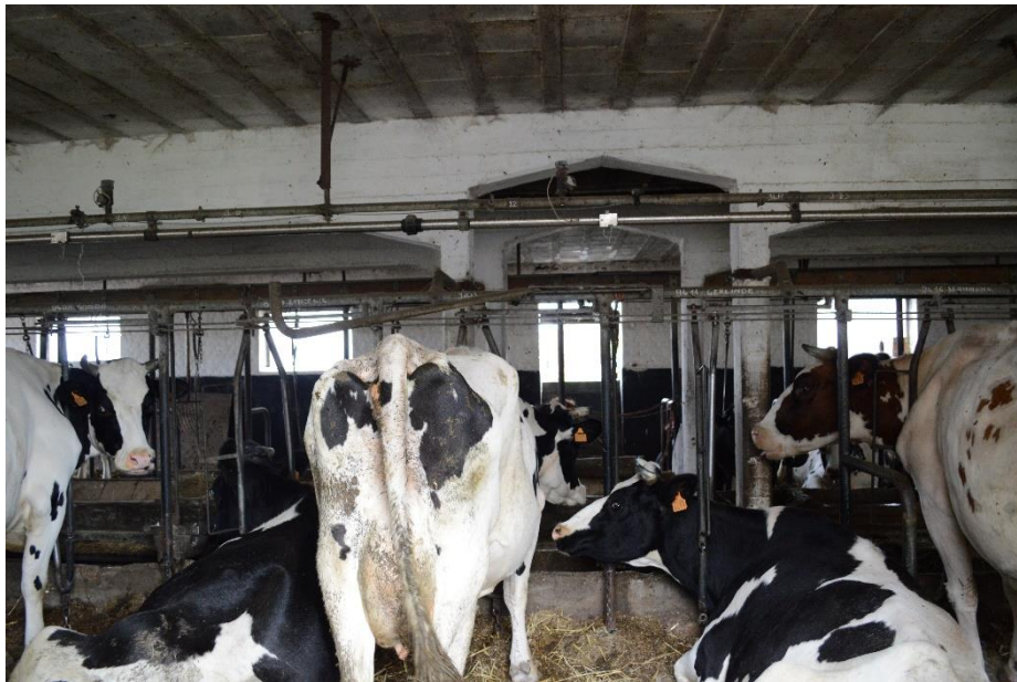
Fig. 33: de betongewelven, geschraagd door betonnen dwarsbalken en zuilen, in de koestal op de hoeve 'Oosthof'* in Ramskapelle (Onroerend Erfgoed).
