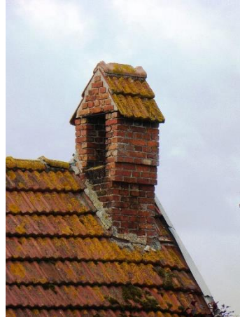
Fig. 37: verluchtingsschoorsteen op koestal van de hoeve 'De Roode Poort'* in Westende (Onroerend Erfgoed).
