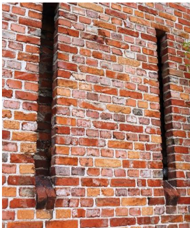
Fig. 47: asemgat in de schuur op de hoeve in de Pilkemseweg 130* in Boezinge (Onroerend Erfgoed).
