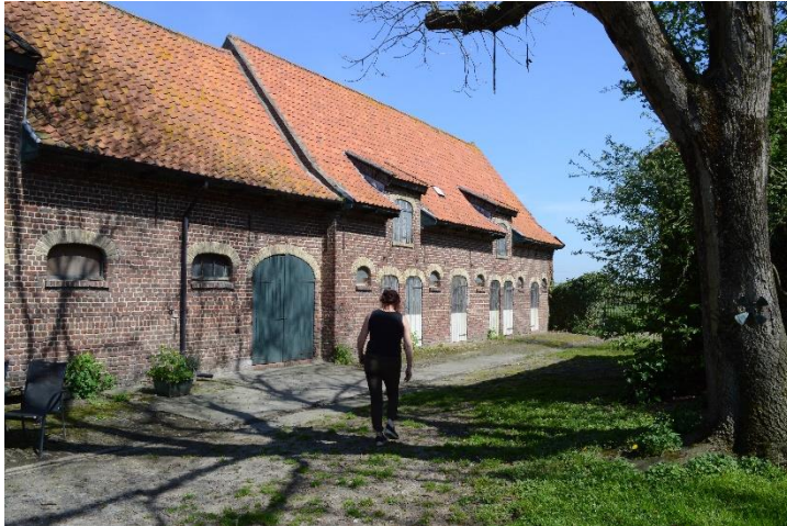
Fig. 25: het voederhok voor de paardenstal op de hoeve 'Madelstede'* in Boezinge is voorzien van een bredere poort. Rechts sluit de varkensstal onder hoger zadeldak aan (Onroerend Erfgoed).
