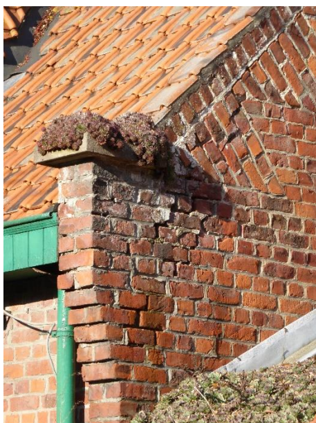
Fig. 21: gevel met vlechtingen en schouderstuk op de hoeve 'Boskasteel'* in Poelkapelle (Onroerend Erfgoed).
