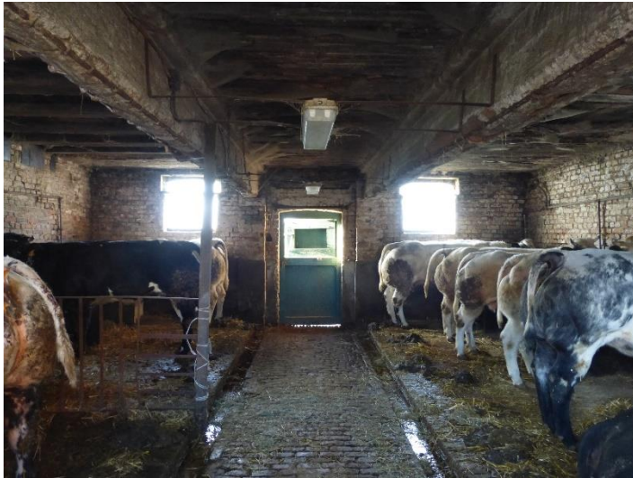
Fig. 29: de koestal op de hoeve in de Zonnebekerstraat 99 in Langemark beantwoordt aan het derde model. Hierbij is de centrale voedergang geflankeerd door twee goten (Onroerend Erfgoed).
