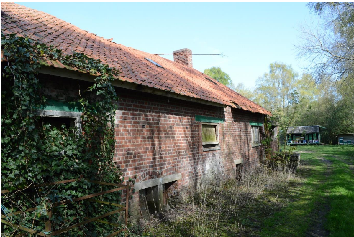
Fig. 41: de varkensstallen op de wederopbouwhoeve 'Boskasteel'* in Poelkapelle (Onroerend Erfgoed).
