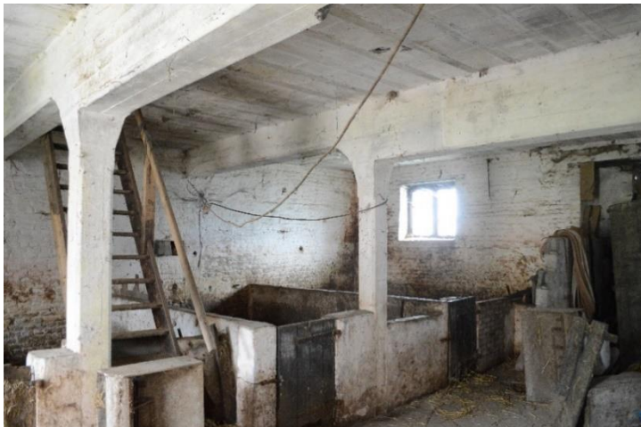
Fig. 39: de betonnen zoldering in de voormalige paardenstal op de hoeve 'Oosthof' in Ramskapelle (Onroerend Erfgoed).
