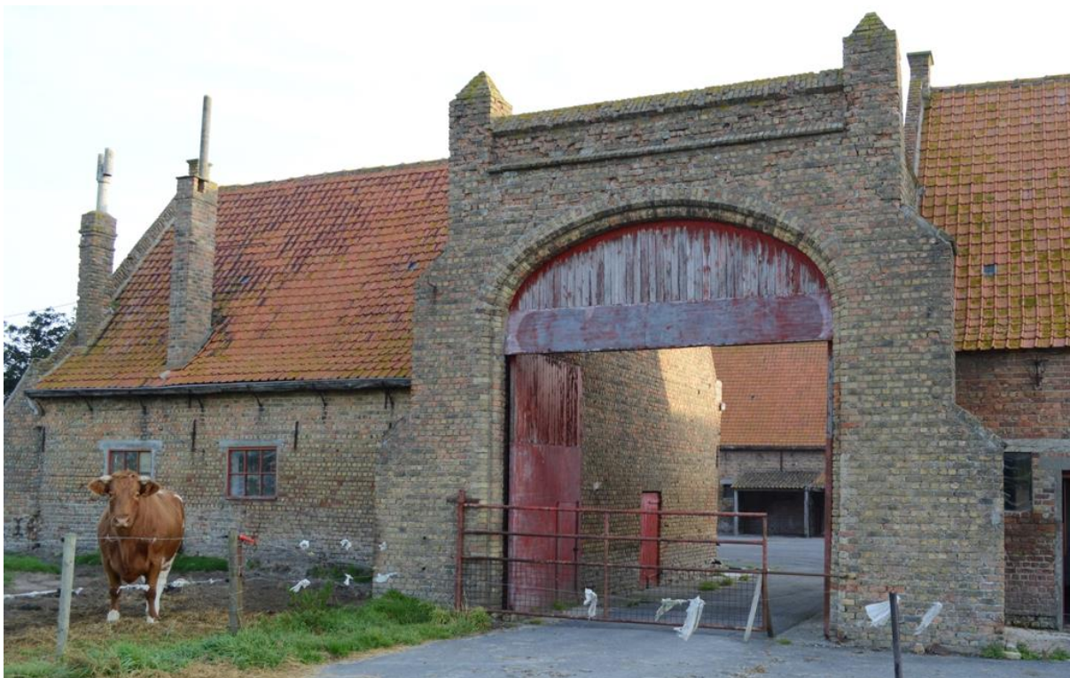
Fig. 17: hoeve 'De Roode Poort' in Westende, ontworpen door architect Théodore Raison (Onroerend Erfgoed).
