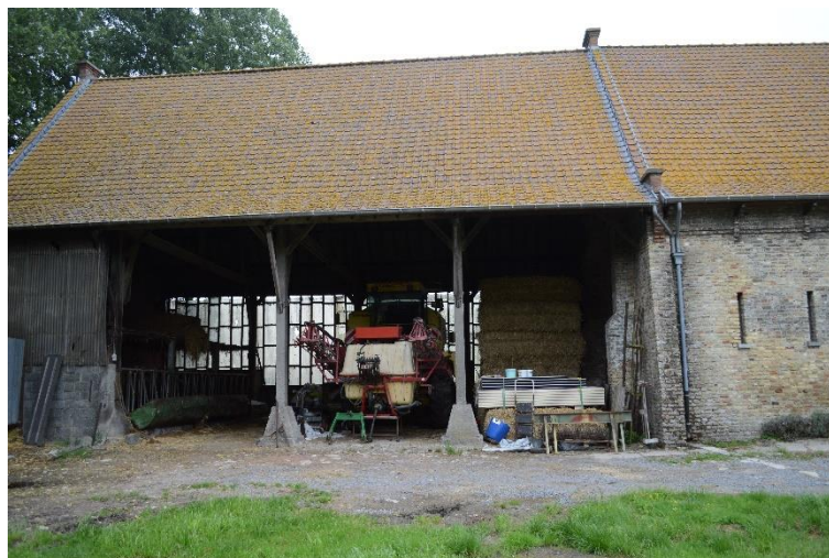
Fig. 46: open hangar op de hoeve 'Oosthof' in Ramskapelle (Onroerend Erfgoed).
