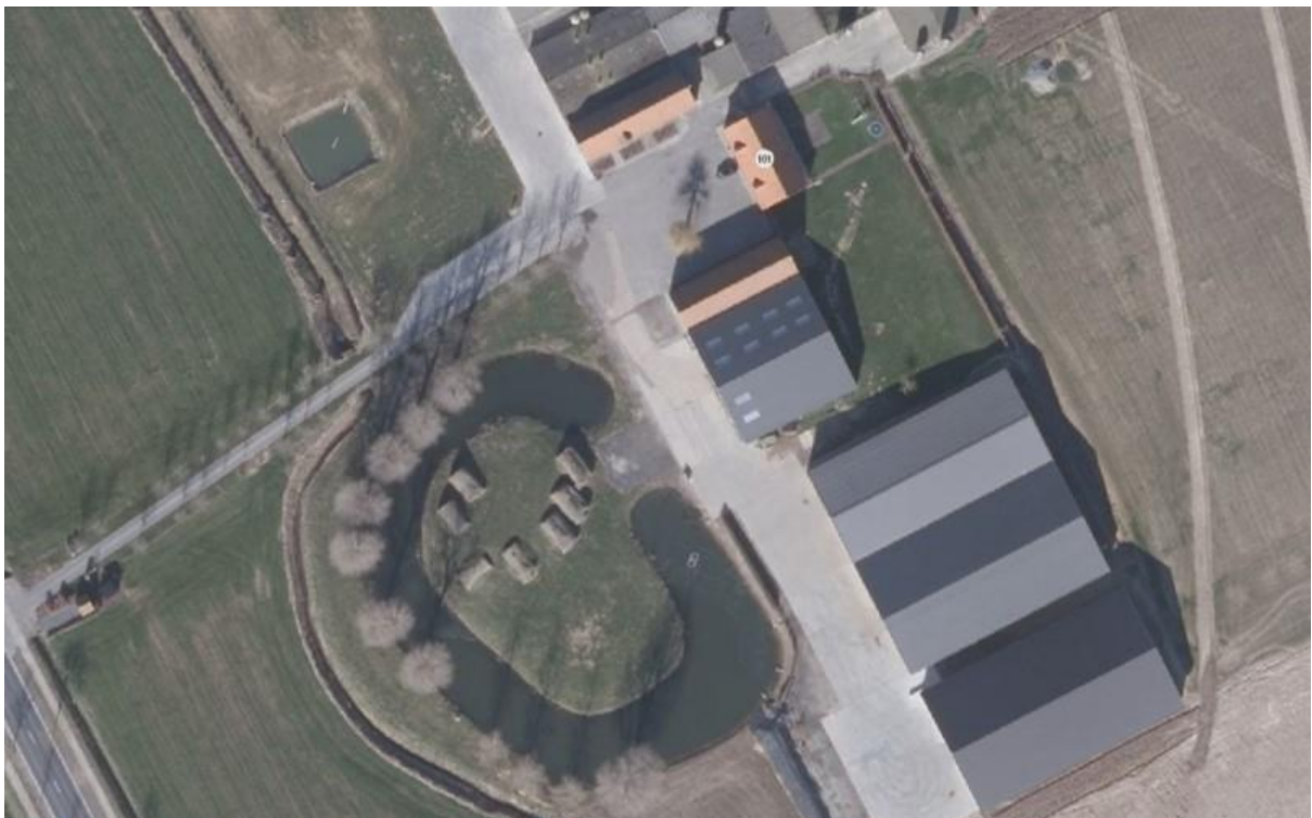
Fig. 10: luchtfoto van de hoeve 'Langhof' in Zillebeke met op het opperhof Britse bunkers (Geoportaal - geo.onroenderfgoed.be).
