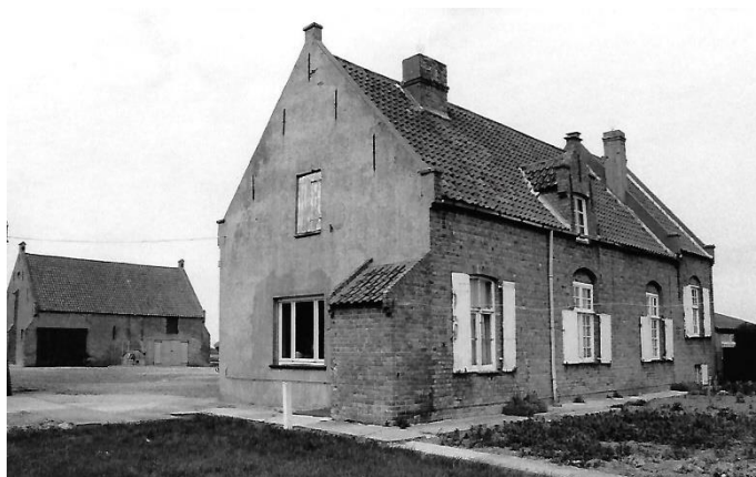
Fig. 24: buitentoilet tegen zijgevel van de boerenwoning op de hoeve 't Geuzegat'* in Mannekensvere (1996, fotoarchief Onroerend Erfgoed).
