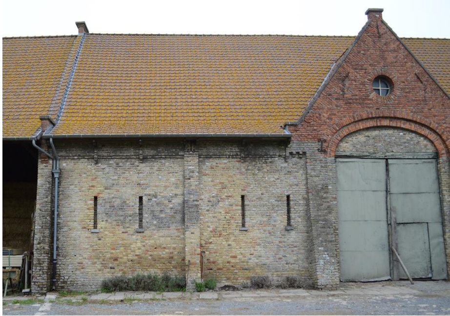
Fig. 48: asemgat in de schuur op de hoeve 'Oosthof'* in Ramskapelle (Onroerend Erfgoed).
