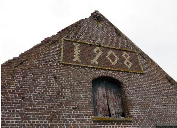
Fig. 6: het op de zijgevel van de schuur vermelde jaartal "1908" op de hoeve in de Vlamertingestraat 61 in Vlamertinge (Onroerend Erfgoed).
