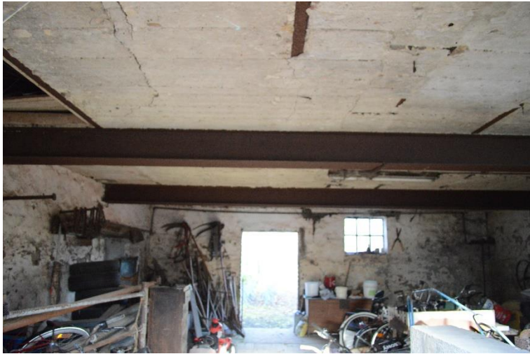
Fig. 35: betonnen zoldering volgens het procédé Casteleyn in de koestal op de hoeve 'De Kleine Bambrug'** in Westende (Onroerend Erfgoed).
