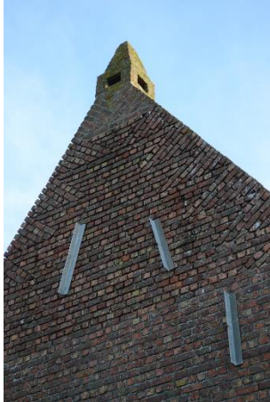
Fig. 37: verluchtingsschoorsteen op koestal van de hoeve 'De Roode Poort'* in Westende (Onroerend Erfgoed).
