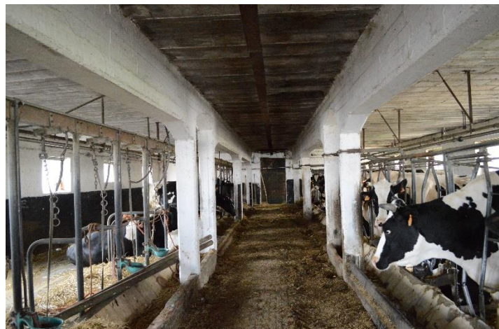
Fig. 32: de koestal op de hoeve 'Oosthof'* in Ramskapelle beantwoordt aan het vierde model. De centrale voedergang wordt geflankeerd door achtereenvolgens voederbakken, een staanplaats voor de koeien, een goot en een mestgang (Onroerend Erfgoed).
