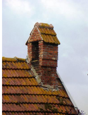
Fig. 37: verluchtingsschoorsteen op koestal van de hoeve 'De Roode Poort'* in Westende (Onroerend Erfgoed).
