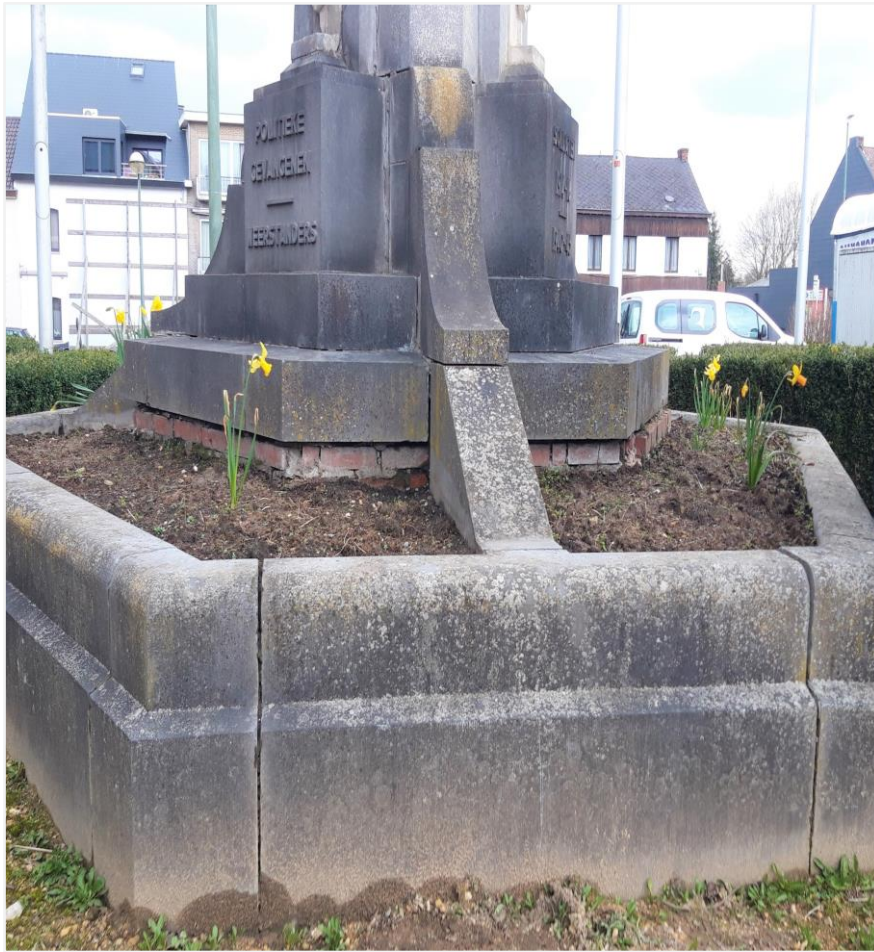
Foto 4: Detail van het basement.
