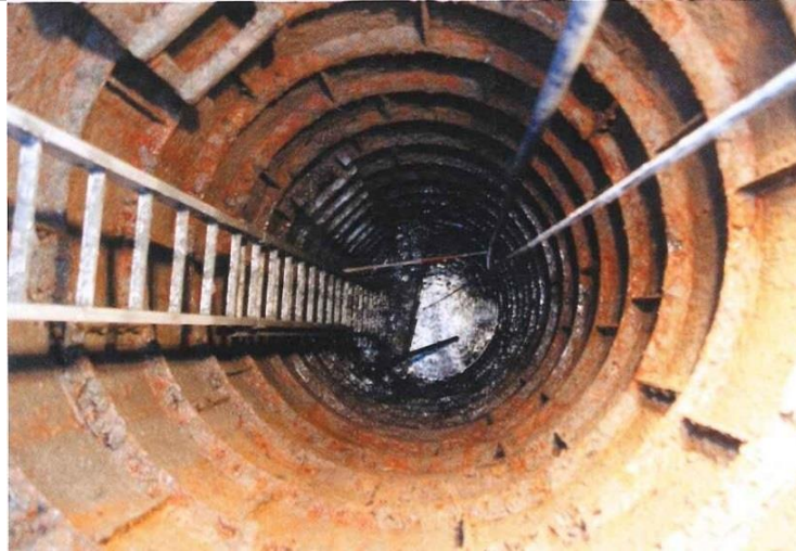
Zicht op een Britse schacht met stalen ringen bij 'Lancashire farm' in Ieper. Bron: BARTON P., DOYLE P. en VANDEWALLE J. 2004 (ed. 2010): Beneath Flanders Fields , stroud, 82.
